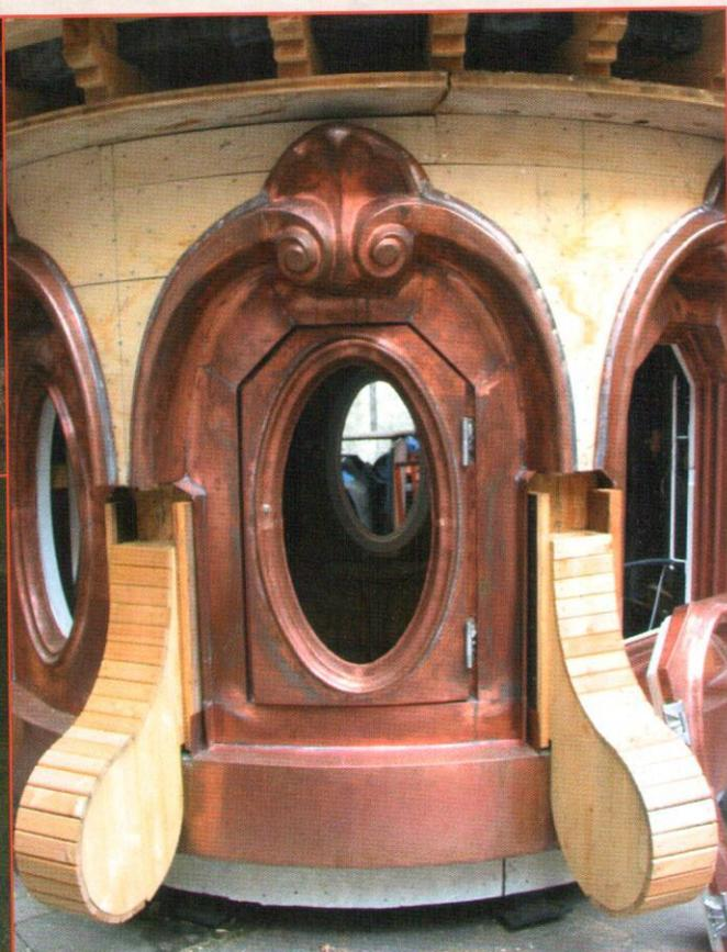
Das aus Ton modellierte Gesims mit Schlussstein zeigt bereits die Form des später aus Kupfer getriebenen Schmuckgesimses. Die geschwungenen Bauteile fügen sich harmonisch in das Gesamtbild der Holzlaterne ein, wobei speziell ausgebildete Fensterflügel diesen Eindruck zusätzlich unterstreichen.
