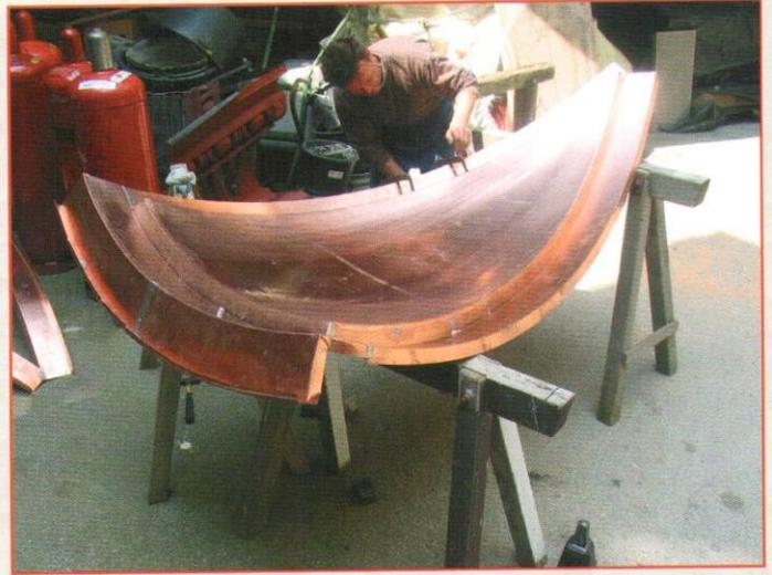
Volle Kupferrieten und Lötnähte verbinden die Dachsegmente und Gratleisten.
